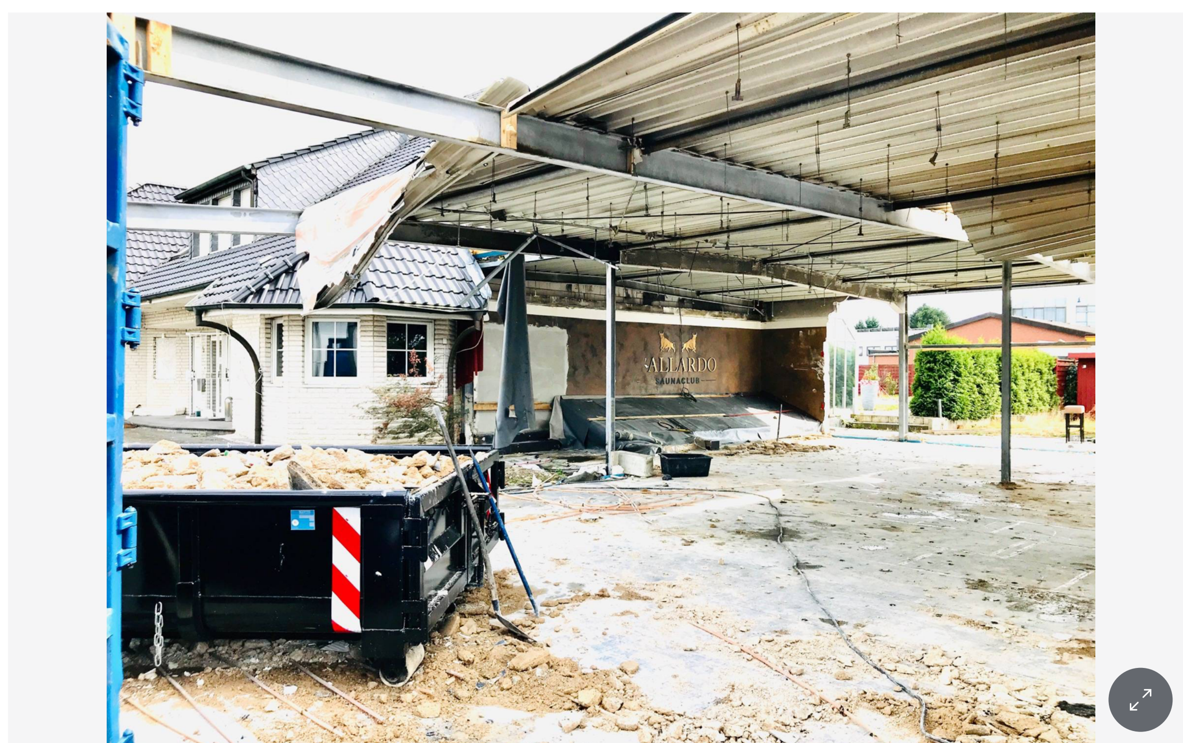
Die Abrissarbeiten an dem Etablissement laufen. Foto: Klaus Nikolei
