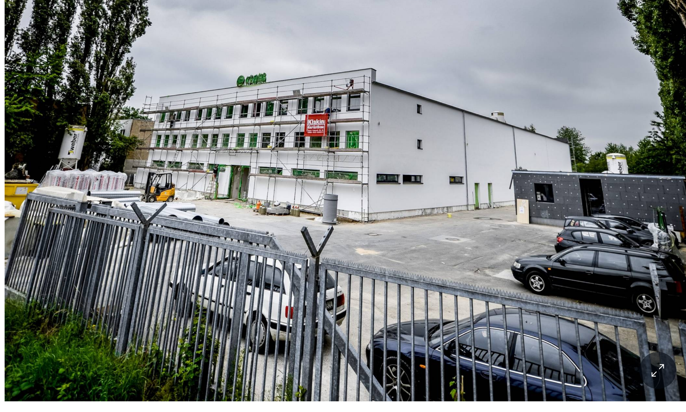
Das Oceans in Rath während der Bauphase 2014. Foto: Endermann, Andreas (end)
