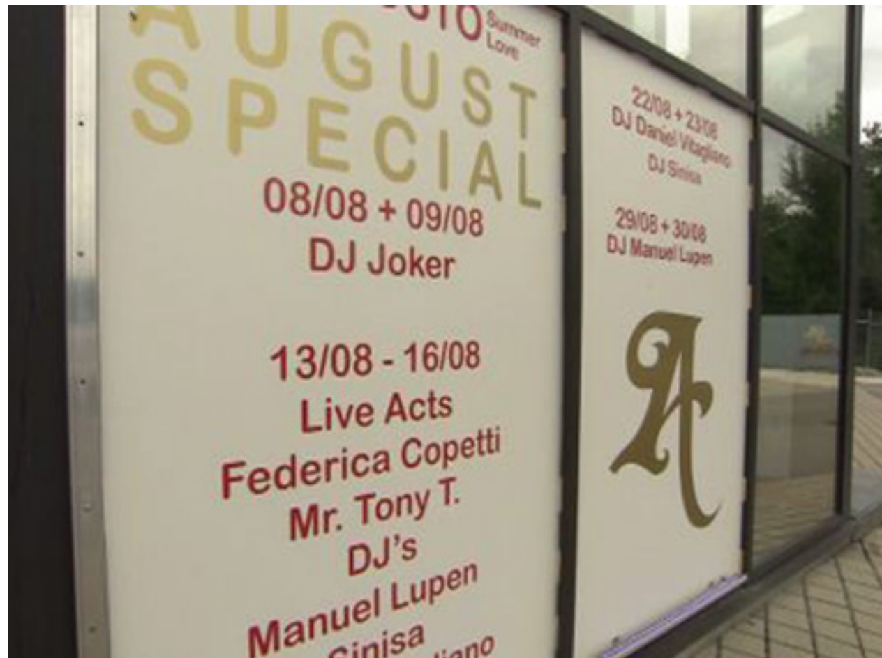
Die beschädigte Fassade wurde abgedeckt.
