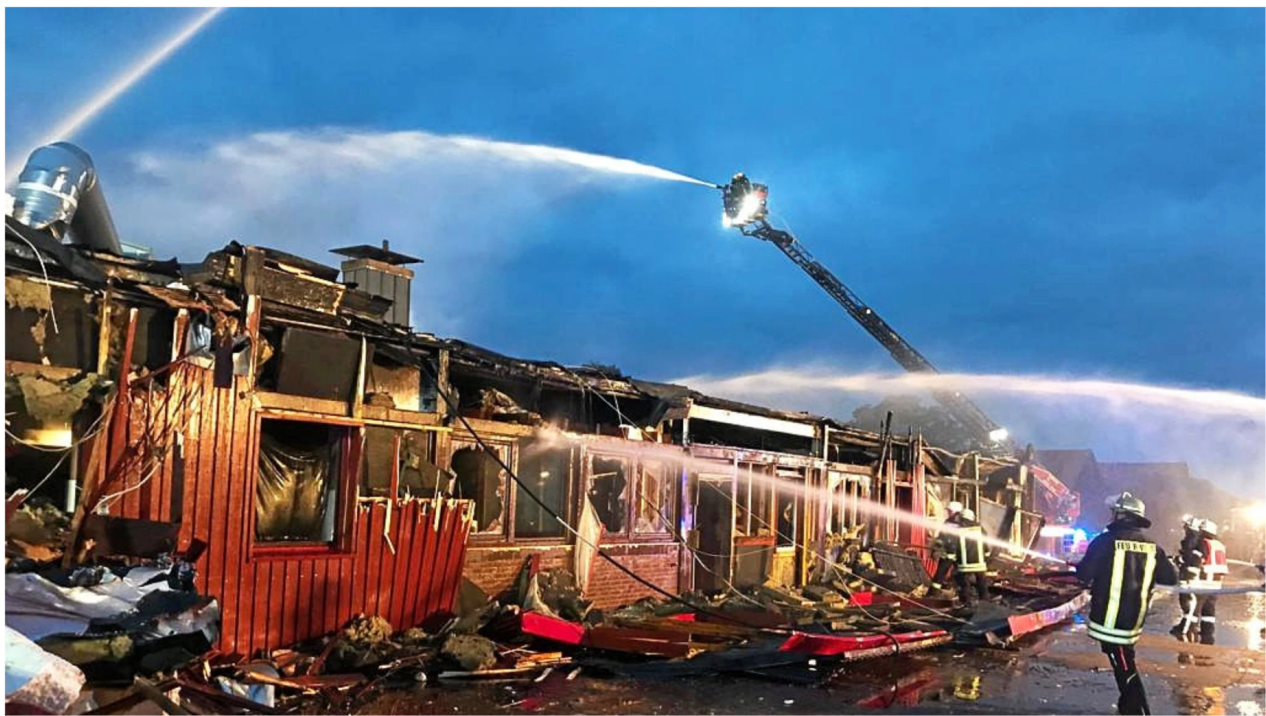
Trotz des Einsatzes der Feuerwehr brannte der Saunaclub in Hamminkeln aus.
